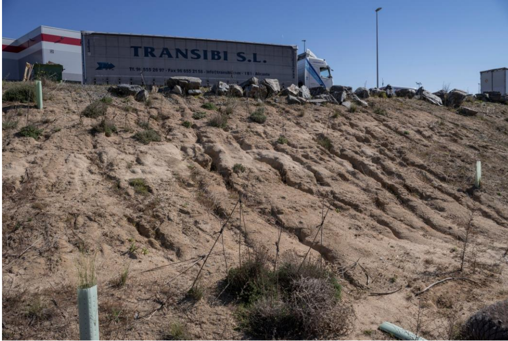
Figura 28. Zona de cárcavas en la que fue imposible plantar durante los trabajos de restauración y que supone un buen nicho ecológico para los albardines.
