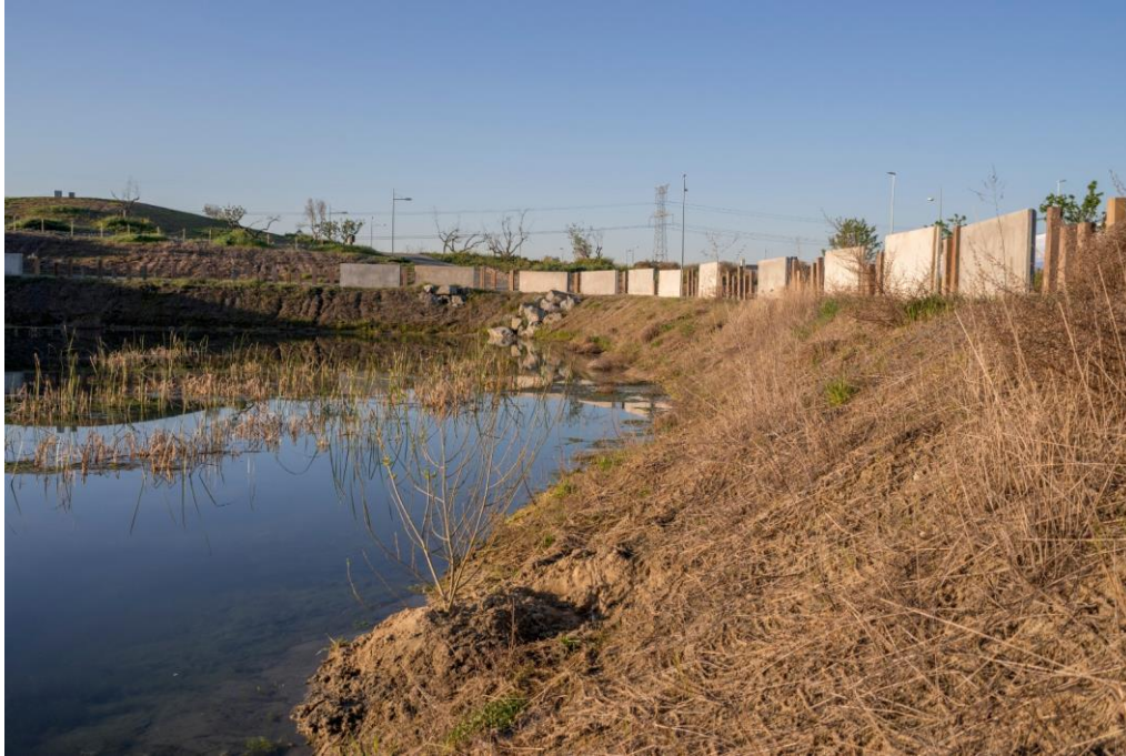
Figura 49. Vista de los taludes de la balsa. Se ha trabajado la vegetación edafohigrófila. Falta matorralización.
