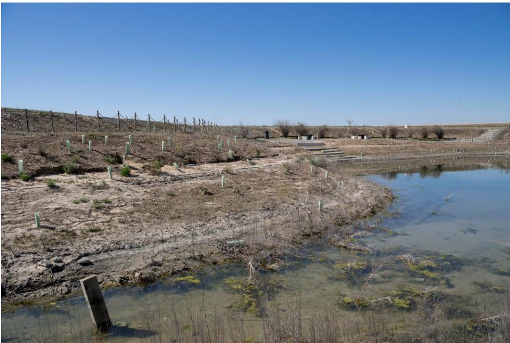
Figura 32. Destalle de la erosión provocada por el agua que además atestigua el alto nivel alcanzado.
