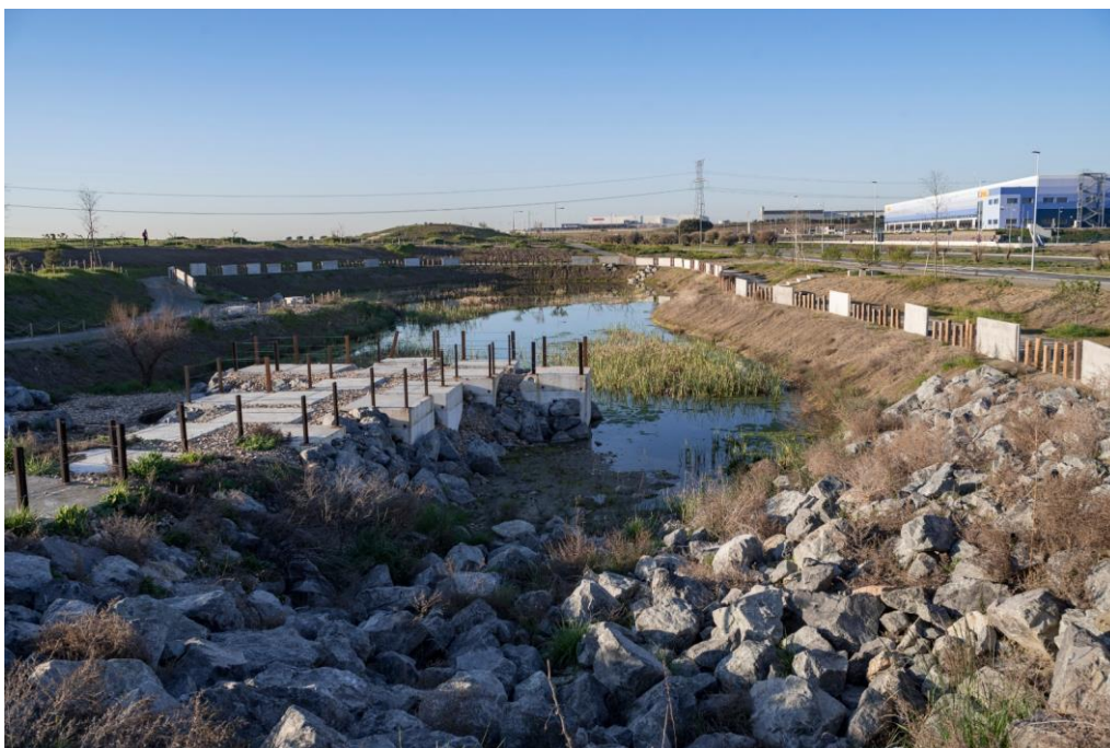
Figura 48. Vista de la balsa de Fase 4.
