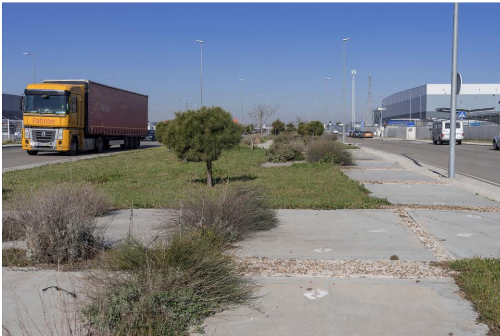
Figura 8. Vista de la mediana B12.
