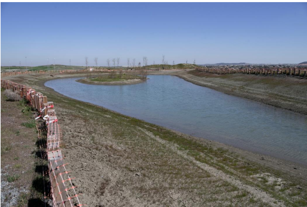
Figura 43. La balsa de los naranjos tuvo que ser impermeabilizada, por el momento se recomienda el favorecimiento de pastos con el objetivo de no deteriorar la cubierta.
