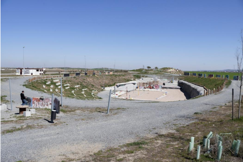
Figura 44. Taludes del Skate Park que podrían ser matorralizados.
